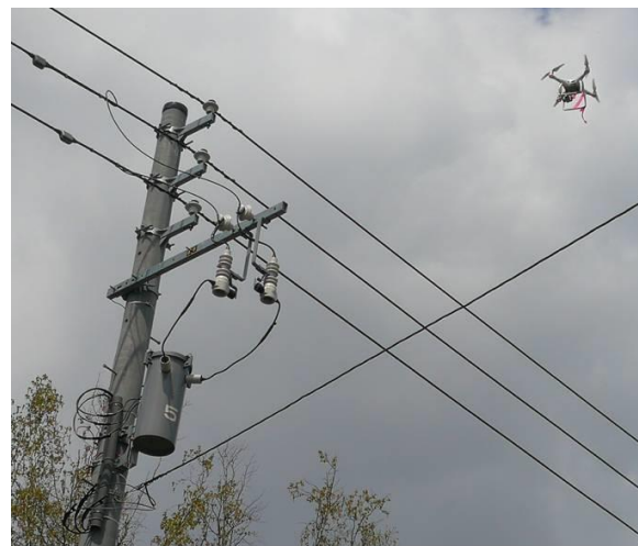
ドローンによる配電設備の点検試験
