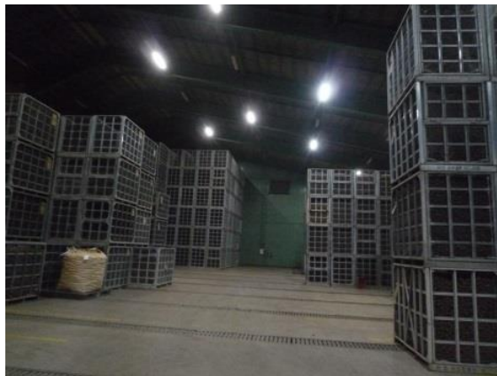
ポテライトが照明による緑化を抑制することで、搬出・保管の作業性・安全性が向上したジャガイモ保管庫
