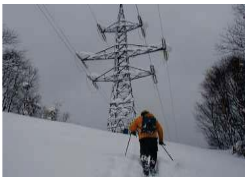
〔送電設備の巡視点検〕
