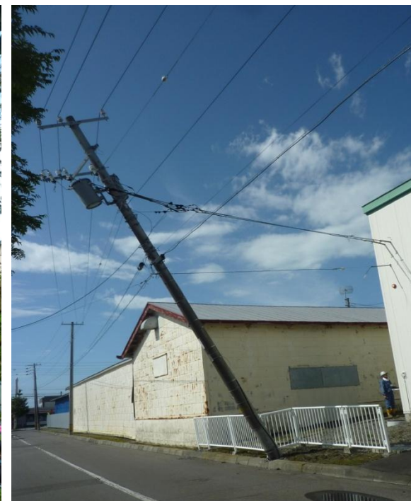
電柱折損・傾斜現場 (沙流郡日高町)
