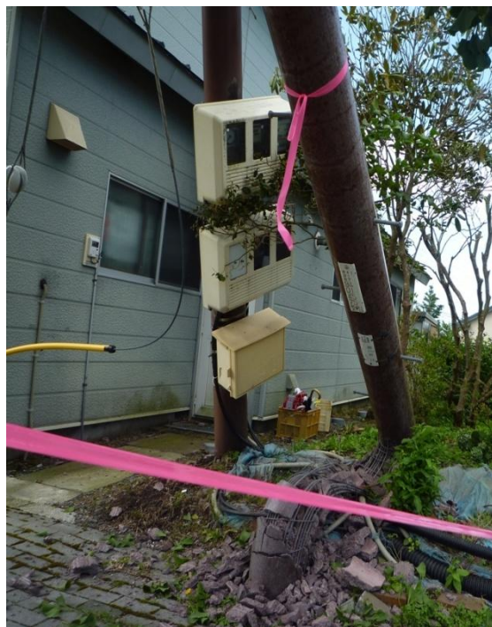
電柱折損・傾斜現場 (沙流郡日高町)
